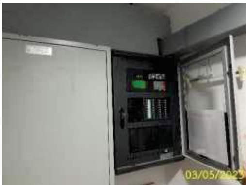
แผงควบคุมสัญญาณเตือนอัคคีภัย
